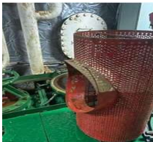
Gambar 9. Filter seachast yang sudah diganti baru
