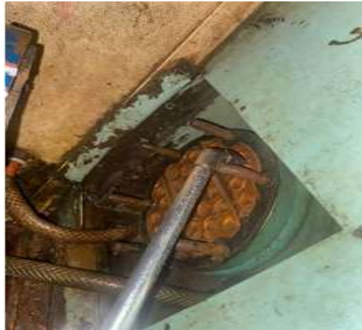
Gambar 8. Pembersihan Menggunakan Angin Bertekanan
