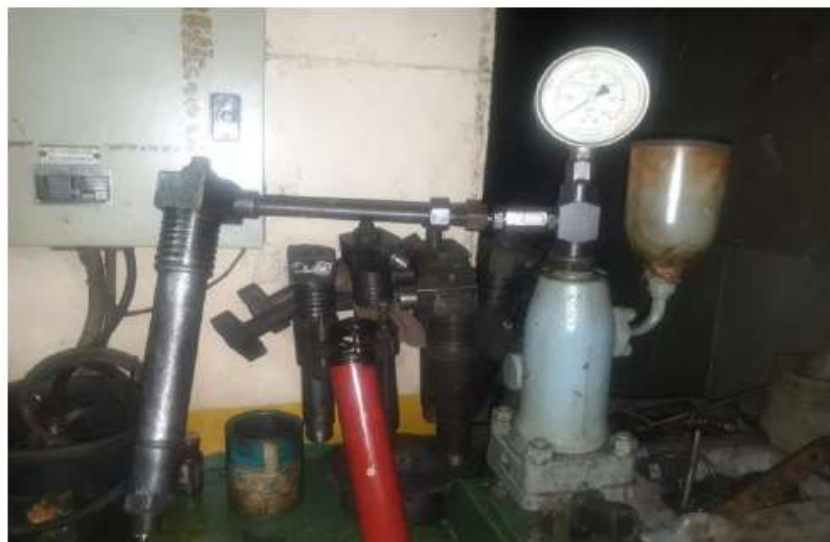
Gambar 4.7 Pengecekan Tekanan Injektor Sumber : Dokumentasi pribadi
