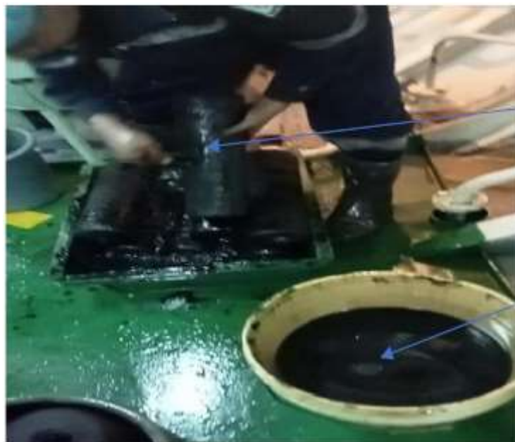
Gambar 4. 11 Pembersihan filter bahan bakar
