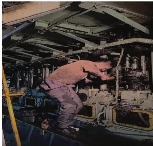
Gambar 2. Pembersih Pipa Nozle LO Sumber : Dokumentasi Pribadi 2023
