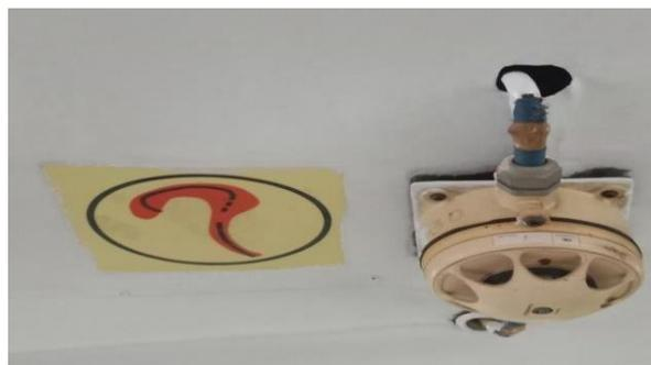
**Gambar 2. Alat Pendeteksi Asap (Smoke Detector) yang kotor**
