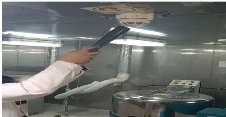
**Gambar 4. Melakukan Pengetasan pada Smoke Detector**
